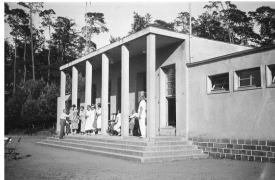
Um 1930, das neue Clubheim, kurz nach der Erbauung
